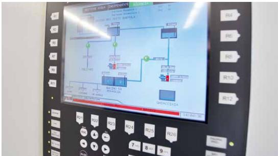
Moderne SPS-gesteuerte Überwachungseinheit für ein Kleinwasserkraftwerk
