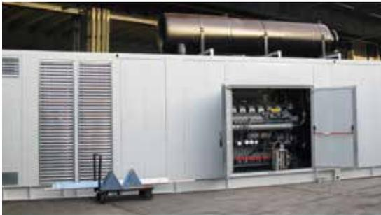
Leistungsstarkes Notstromaggregat für eine öffentliche Einrichtung im Tessin. Leistung: 2.058 kVA
