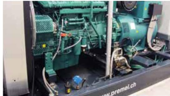
Notstromaggregat für das Krankenhaus Novaggio (Tessin). Leistung: 650 kVA
