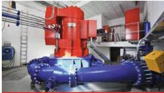
Kleinwasserkraftwerk im Tessin mit einer Leistung von 1.440 kVA
