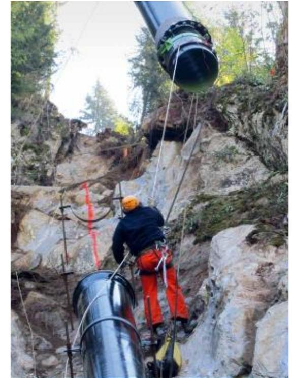
Montage der Druckleitung für den Betrieb eines Kleinwasserkraftwerks im Tessin
