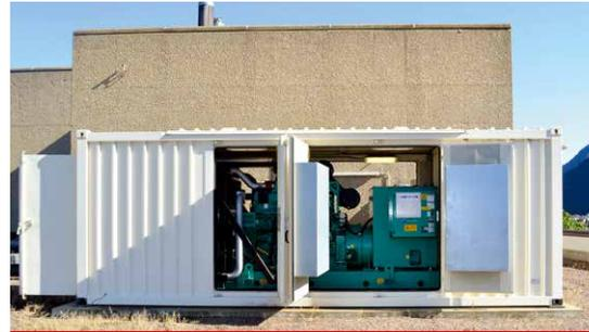
Notstromanlage mit 850 kVA für die Tessiner Kantonalbank, auf dem Gebäudedach installiert
