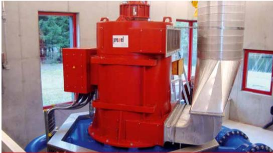
Komplett montierter Generator für das Wasserkraftwerk VAL STREM, Graubünden
