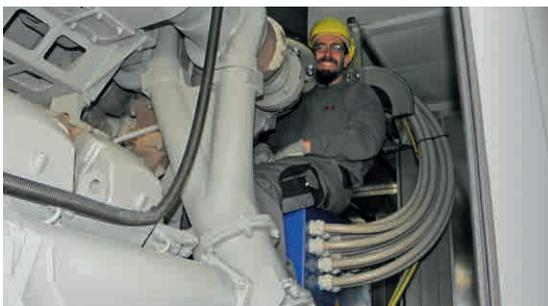
Travaux de montage d'un groupe de secours au Tessin. Puissance supérieure à 2 MVA
