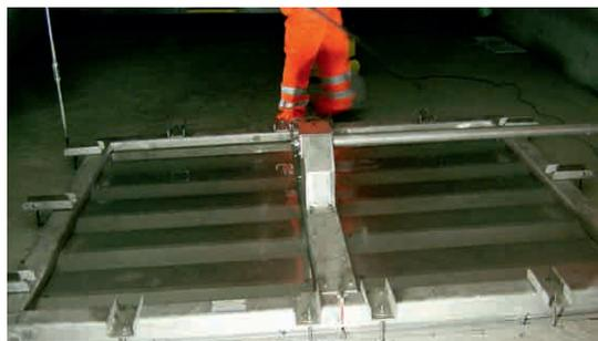
Montage d'un clapet d'aspiration de fumée au plafond d'un tunnel
