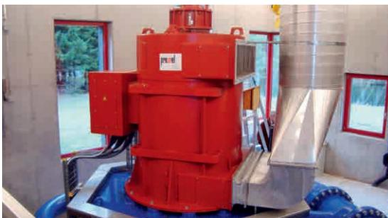
Alternateur complètement monté à la centrale hydroélectrique de VAL STREM/GR
