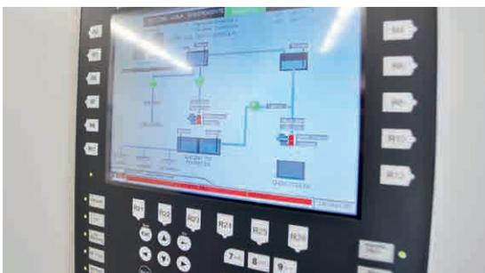
Unité moderne de contrôle pour une microcentrale hydroélectrique gérée par PLC
