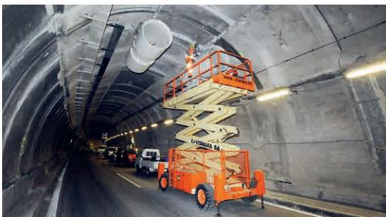
Montage de ventilateurs Premel au plafond d'un tunnel
