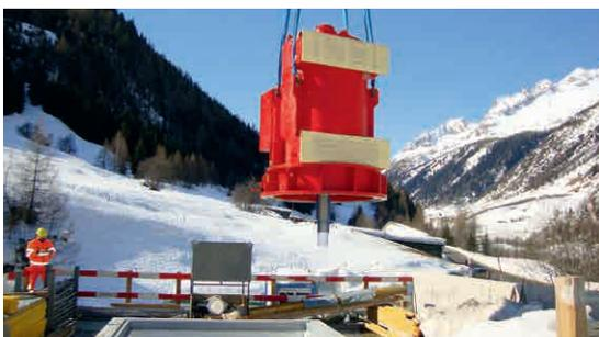
Montage de l'alternateur dans la centrale hydroélectrique d'Ossasco/TI
