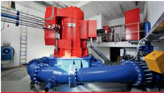
Petite centrale hydroélectrique au Tessin avec une puissance de 1'440 kVA
