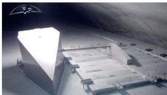
Clapet d'aspiration de fumée intégré au plafond d'un tunnel autoroutier
