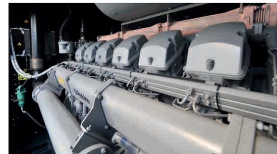
Moteur diesel pour un groupe de secours. Puissance supérieure à 1.8 MVA
